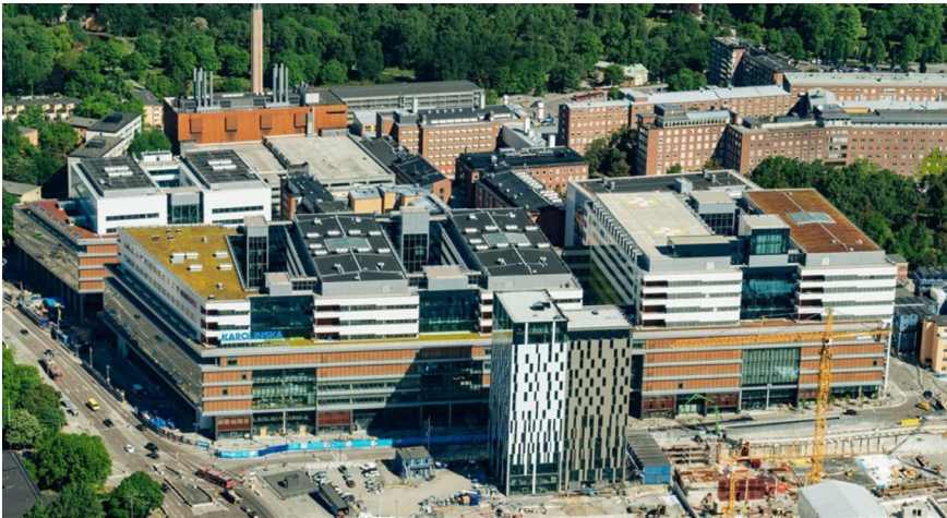
Fig. 2. NKS invigdes i december 2017. Här syns det från söder med Elite Hotel Carolina Tower i förgrunden. Det gamla universitetssjukhuset syns uppe till höger i bilden (utan författare 2022).
