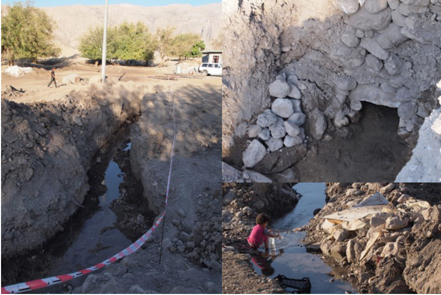
Figur 5. En qanat under renovering i Sulaymaniaprovinsen, irakiska Kurdistan (©Lina Eklund)
