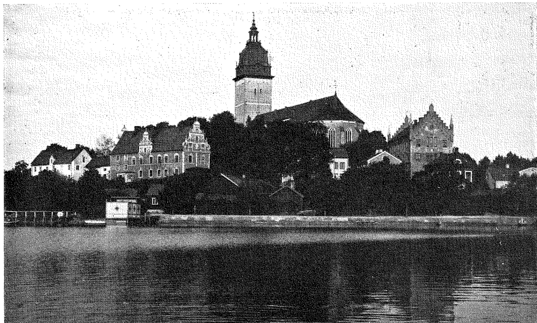
FIG. 2. STRÄNGNÄS. DOMKYRKOPARTIET FRÅN SYDOST.
