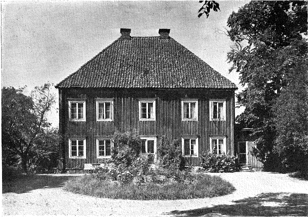
FIG. 35. BYGGNAD MED HÖGT VALMTAK, BOTTORP, S. MÖRE HD.
