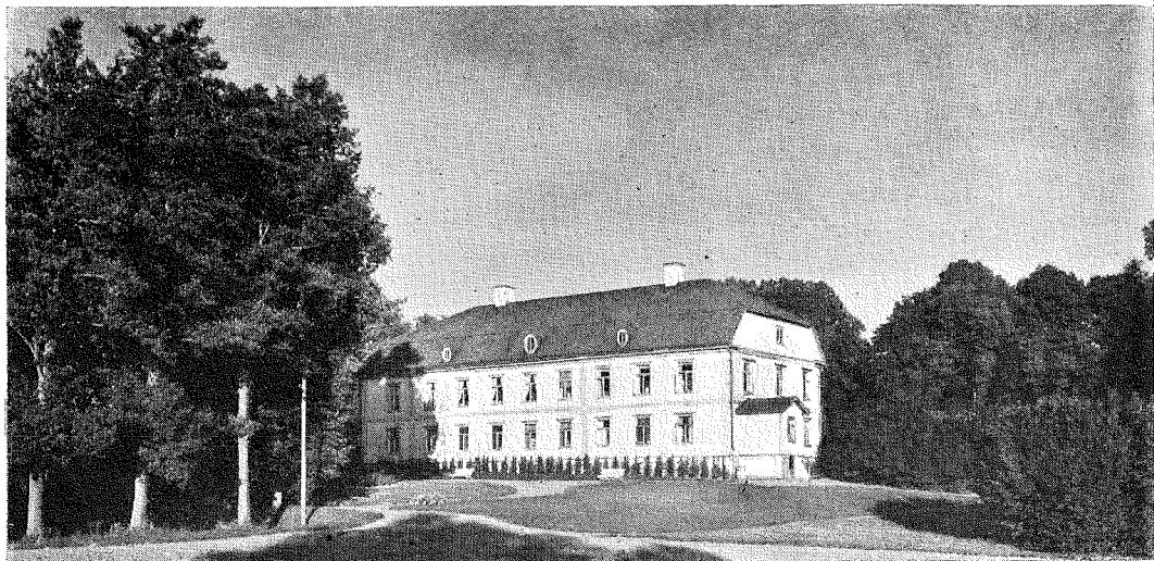
FIG. 40. BYGGNAD MED BRUTET TAK OCH AVVALMADE GAVLAR, FRÅN OMKRING ÅR 1800, BERGA, HANDBÖRDS HD.
