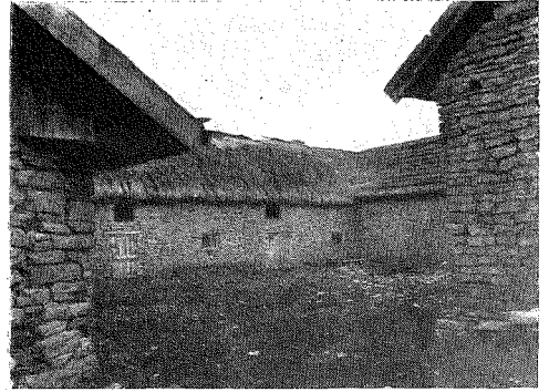
FIG. 14. FÖR ÖLAND TYPISK LADUGÅRD AV KALKSTEN, VEDBY, ÖLAND.
