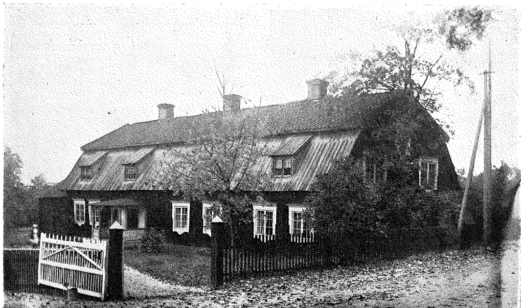
FIG. 34. BYGGNAD TÄCKT MED BRÄDER I UNDRE, MED TEGEL I ÖVRE FALLET, BÖTTERUM, HANDBÖRDS HD.
