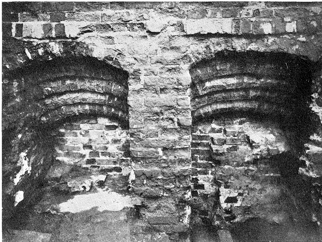
FIG. 3. STOCKHOLMS SLOTT. DEN ÄLDSTA PORTALEN, DUBBELPORTALEN, SEDD FRÅN BORGÅRDEN SEDAN STÖRRE DELEN AV IGENSÄTTNINGARNA BORTHUGGITS. ÖPPNINGARNAS ÖVERSTA BÅGE BEFINNER SIG UNG. 3 METER UNDER BORGÅRDENS MARKYTA.
