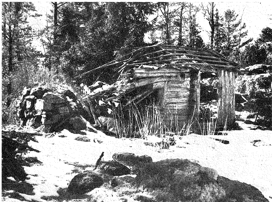
FIG. 3. HUS, ERIKSLUND, SALEM SN, SÖDERTÖRN. STENRÖSET ÄR ELDSTADEN; RUMMET MED KNUTTIMRADE VÄGGAR OCH SVALEN INKLÄDD MED BRÅDER. E. JENSEN FOT. 1925.
