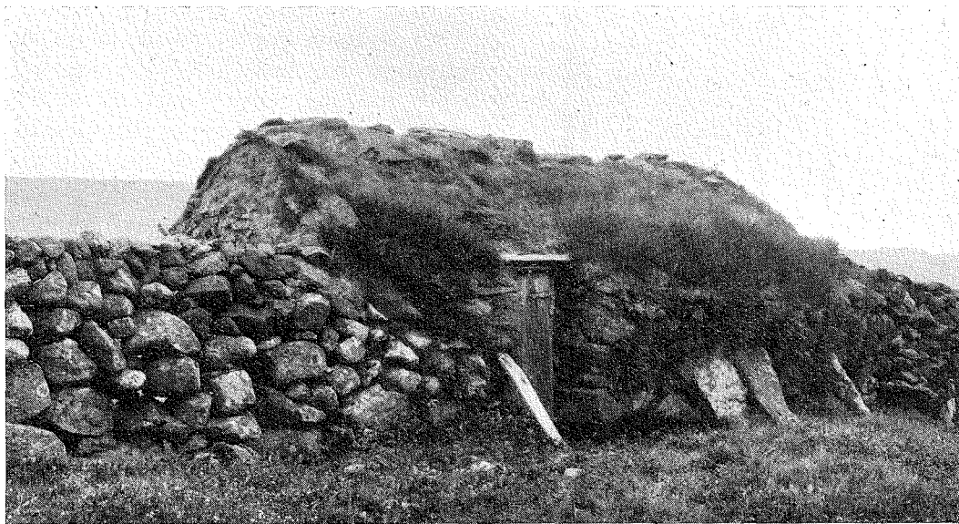
FIG. 24. SODNHUS, DÄRI SÄDEN UGNTORKAS OCH TRÖSKAS. SAND, SANDÖ.
