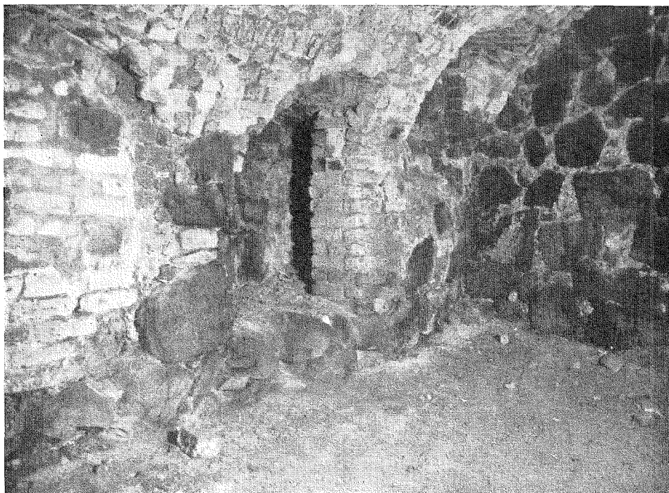
Fig. 9. Kontrollstyrelsens hus, kv. Cepheus 2 och 3. Interiör av källaren i "norra huset" (Cepheus 2). Till vänster ytterväggen mot Svartmangatan, med nischer och öppningar, delvis senare igensatta.
