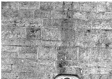
Fig. 9. Regelbunden skiftesläggning i tunnt murbruk, korgaveln, Söne kyrka, Västergötland. A. Roland fot. 1912.
