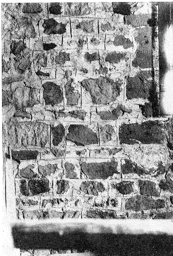
Fig. 12. Mur inuti tornet, kvaderristad, Skånella kyrka, Uppland. Efter Sveriges kyrkor: Uppland, IV, fig. 348.
