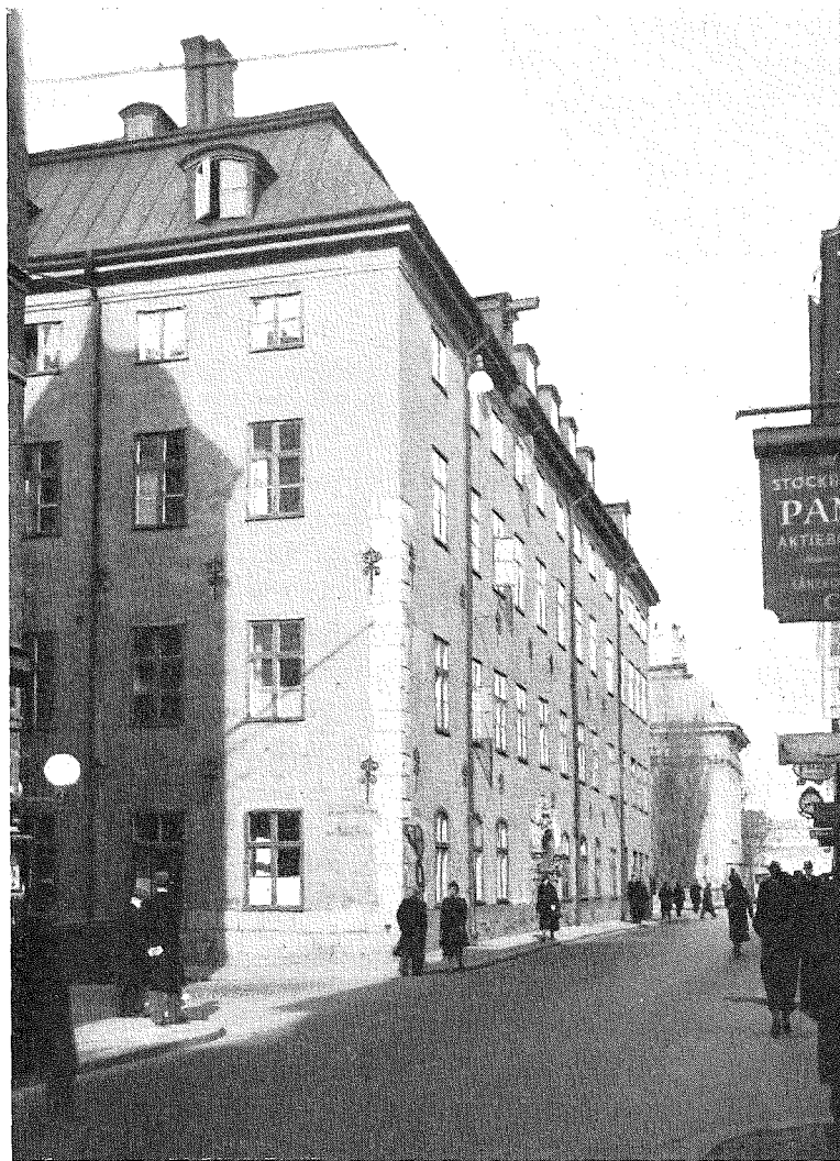
Fig. 13. Ryningska palatset, Stora Nygatan 2, Stockholm. Fasaderna mot Gråmunkegränd och Stora Nygatan; i bakgrunden skimtar Riddarhuset. Palatset har, såsom framgår av ankarlutarna och de bevarade hörnkedjorna, ursprungligen varit tre våningar högt (botten-våning och två våningar) samt haft en fasad mot Nygatan om 8 fönsteraxlars längd.
