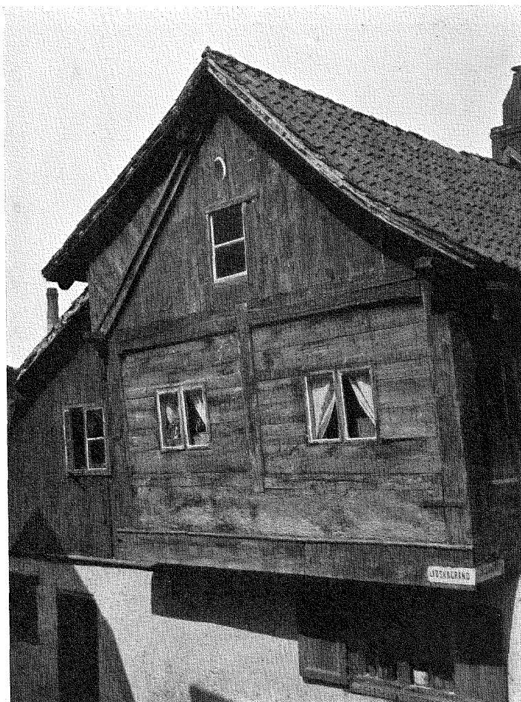
Fig. 5. Hus i skiftesverks-(bul-)konstruktion. Mellangatan, Visby.
