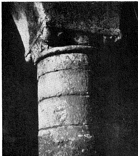
Fig. 42. Tallinns nunnekloster. Det mindre rummets kolonn. Foto O. Grohmann.
