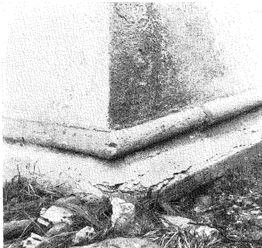
Fig. 3. Sockeln vid byggnadens sydvästra hörn.
