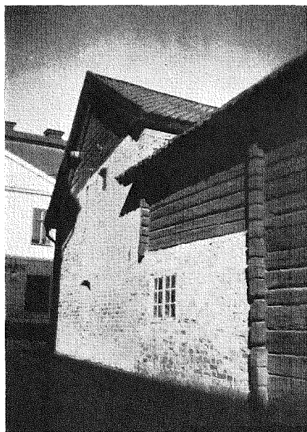
Fig. 3. Arbogahuset sett från Baggensgränd.
