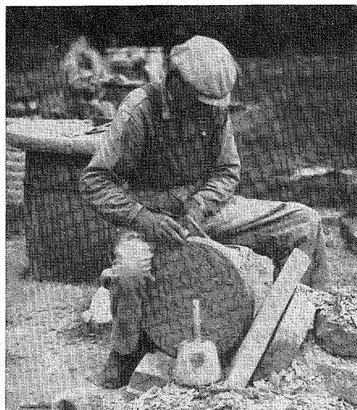
Fig. 19. Stenens slutgiltiga tjocklek uppritas med ritmättet.
