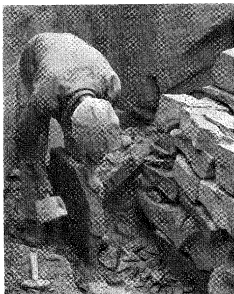
Fig. 12. Slipstensämnet nackas med nackklubban.
