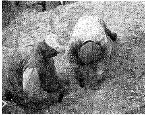
Fig. 6. Krossning av kalksten till förladdningen.
