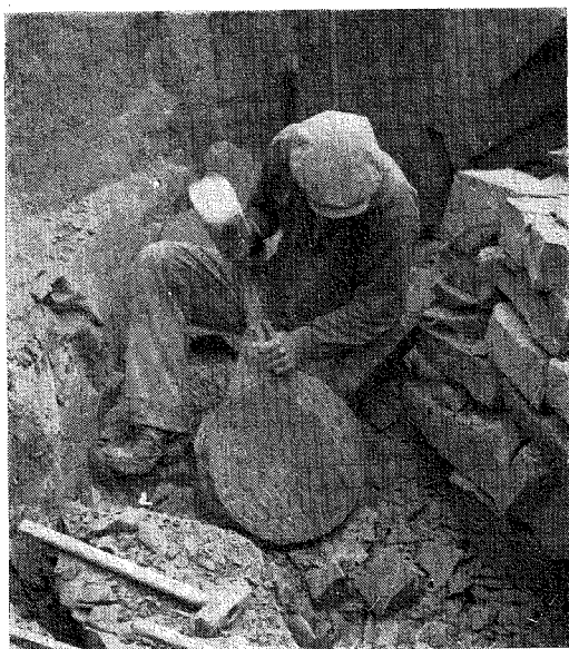
Fig. 14. Förstlagersidan rivs upp med spetsjärn och klubba.
