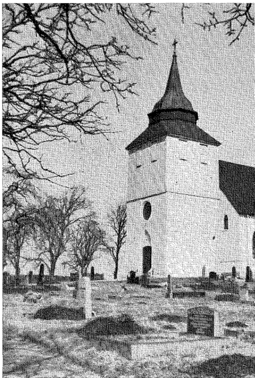
7. Det starkt förändrade medeltida tornet i Tegneby kyrka, Bohuslän. (Av ett i kyrkans sakristia befintligt fotografi, taget före medeltidskyrkans rivning, framgår att tornet i väster haft en romansk portal samt däröver en smal tornlugg, vilken vid kyrkans ombyggnad utvidgats till det nuvarande runda fönstret.) Till höger på tornets sydsida, som vid marken mäter 7,6 m i längd, och en meter från långhusets västgavel sitter det lejonhuvud, som före kyrkans ombyggnad 1891 troligen haft sin plats i långhusets sydvästra hörn. Likbeläget med lejonhuvudet, ehuru på tornets norra sida, sitter den i fig. 8 avbildade stjärnornamenterade stenen. Foto från sydsydväst förf. 9 april 1954.
