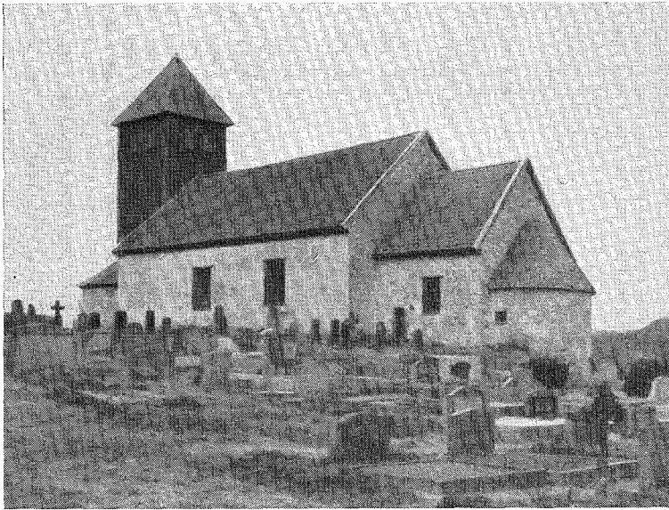
1. Bokenäs ödekyrka, Bohuslän. Kyrkans långhus, kor och absid äro med all sannolikhet uppförda samtidigt. Foto från sydöst förf. 3 maj 1954.
