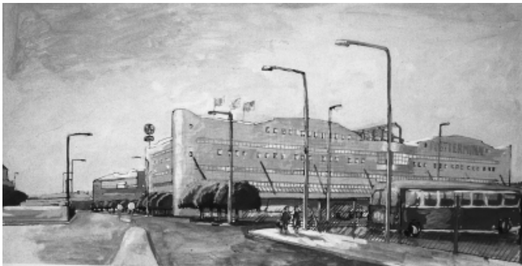
Tillbyggnad av postterminalen i Göteborg. Tillbyggnaden erhöll 1988 års hedersnämning för god byggnadskonst i Göteborg.
