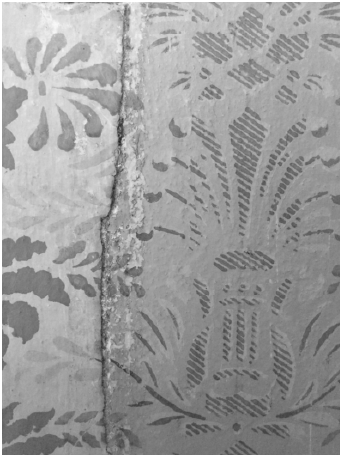
8. Schablonmåleri i Gästgivars. Pigment, bindemedel och underlag, liksom teknik, handlag och tillvägagångssätt är sådant som i projektet analyseras med hjälp av olika metoder. Foto: Ingalill Nyström.
