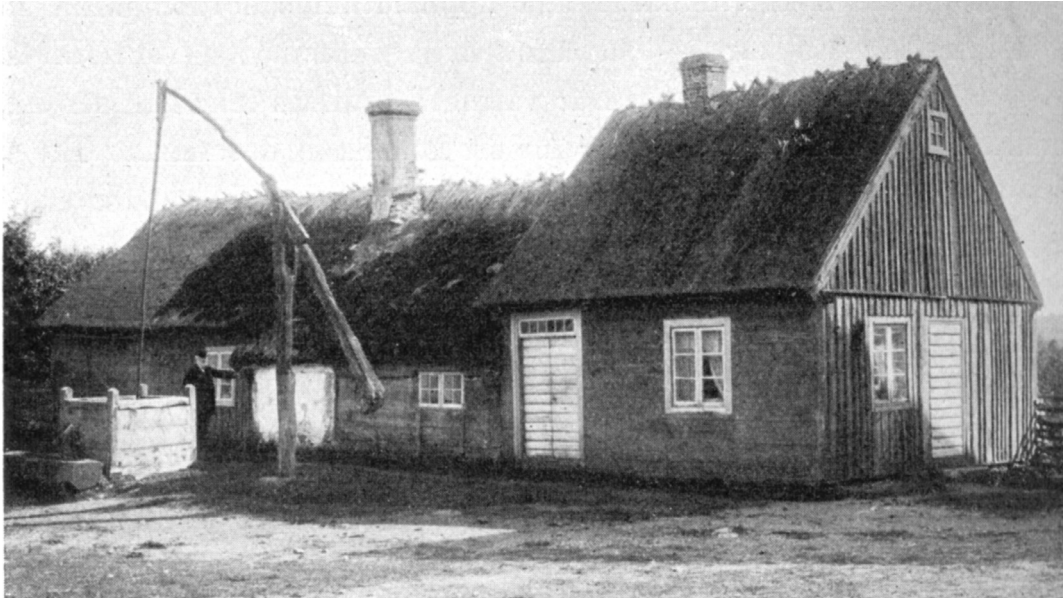
Fig. 12. Brunnjung med stolpvind, Håglinge socken, Skåne. Erixon 1930 fig. 25.
