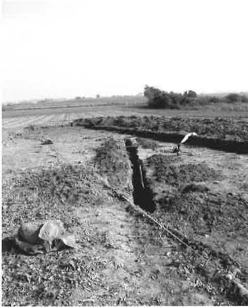
Fig. 1. The drainage ditch in Stora Slågarp.
