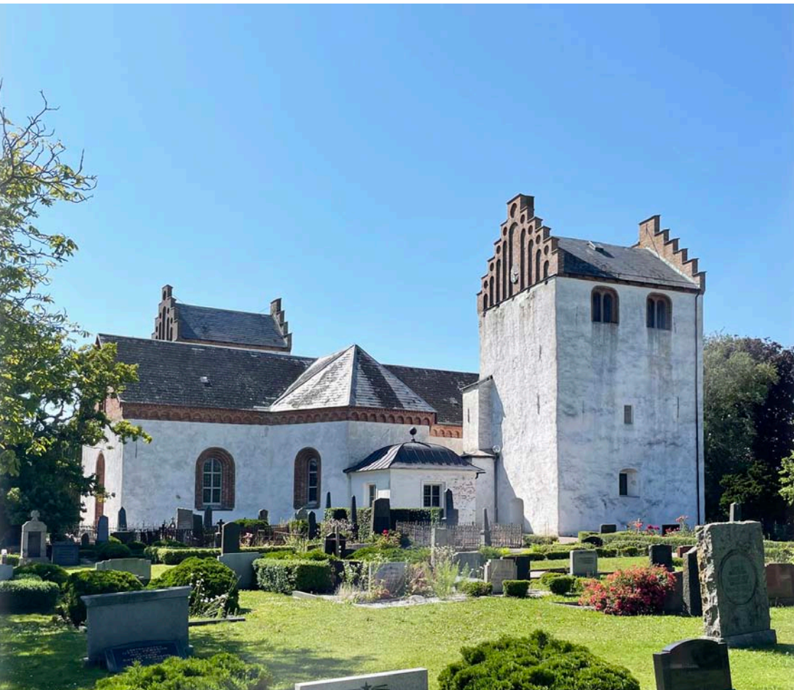
Fig. 1. Löderup kyrka, Skåne, sedd från öster. Kyrkans ursprungliga delar dateras till 1100-talet. I början av 1860-talet revs kor, absid och delar av långhuset (jfr fig. 5) och ersattes med nytt kor och breda korsarmar uppförda efter ritningar av C. G. Brunius. Sakristian mot öster tillkom 1929. Till höger en fristående kastal, troligen från 1400-talet. Foto A. Landen 2024.
