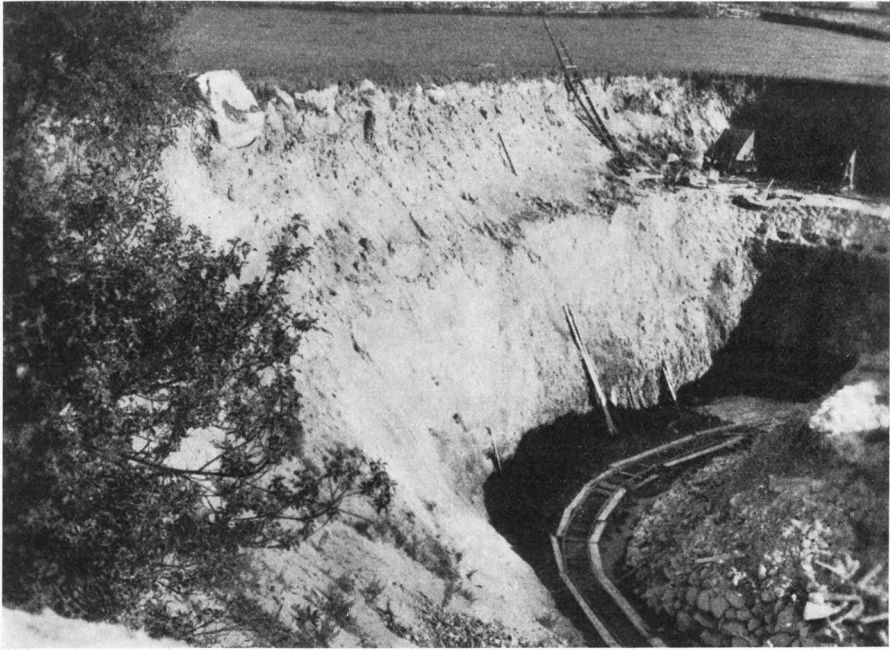
Fig. 4. Kalkbrottet vid Åkarp. Det ca. 5 m tjocka kalklager, som nu är föremål för utvinning, har karaktären av lokalmorän. Det täckes av ett ca. 3 m tjockt skikt av urbergsmorän. Kontakten mellan kalk- och stenig urbergsmorän är på bilden väl synlig. På grund av det torra läget — grundvattnet sipprar in i brottet först ca. 1 m ovan botten — präglas vegetationen blott föga trots kalkens relativa mäktighet. — Förf. foto 1. 7. 1941.
